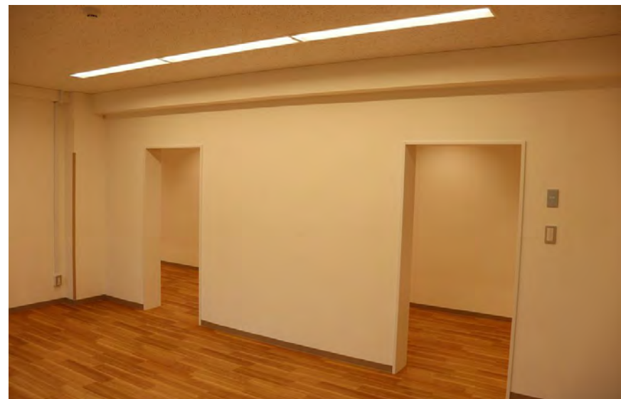
間仕切り壁を撤去し寮室2室を保育室1室に模様替え
