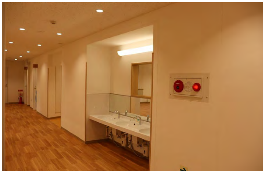
車いす対応のため下部をオープンに
