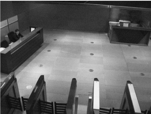
点状ブロックが未設置
