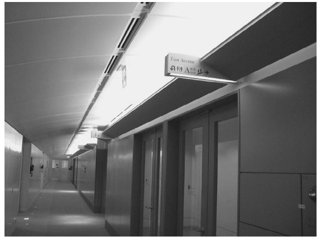
避難サインが進行方向に対して水平に設置され、見づらい
