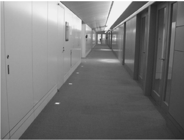
手すり・車椅子フットレストあたりが未設置
