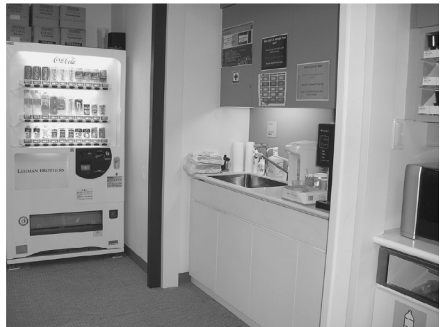
流し台の下に、車椅子使用者のひざ下が入るスペースがない
