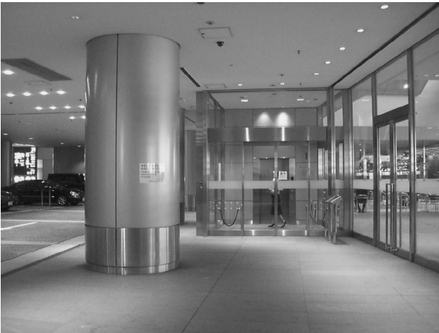
車寄せから建物出入口まで誘導ブロックや音声誘導装置が設置されていない
