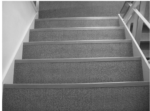
段鼻と踏面とのコントラストが低い
