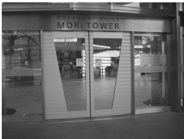
出入口から受付まで誘導ブロックが設置されていない
