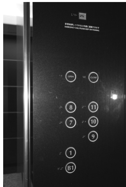
(参考) 三田オフィスエレベータの点字
