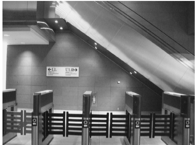
エスカレータの下部空間が通行可能となっており、視覚障がい者が頭をぶつける危険がある
