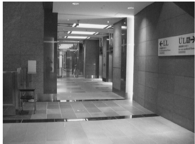
誘導用ブロックが敷設されていない
