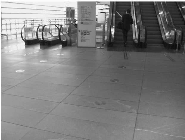
出入口から受付まで誘導ブロックが未設置
