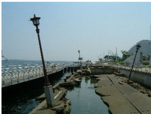
阪神淡路大震災の被害の大きさを実感させる。（神戸港震災メモリアルパーク）
