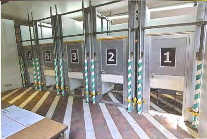
〔写真2〕上下を開けて風通しよく 写真は、待合ブース。人の呼気は温かく 上昇するという。そのためブースの上下を 開けて下から上へ、効率的に空気が流れ るようにしている (写真:下も清水建設)
