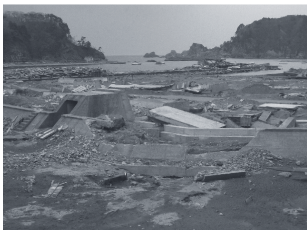
写真 破壊された田老町の堤防・著者撮影
