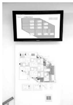
エリア毎に照明・空調が容易なビジュアルスイッチパネル
