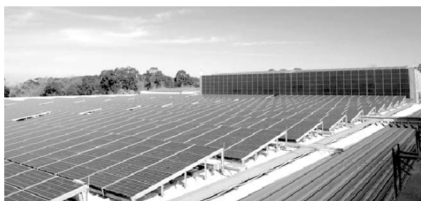
建築物のすべてに設置された太陽光パネル
