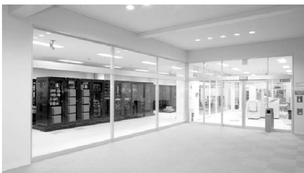
サーバー室もガラス張り
