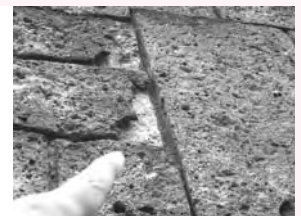
写真2 外装材の剥離状況
