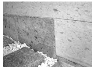
写真3 内装材の剥離状況
