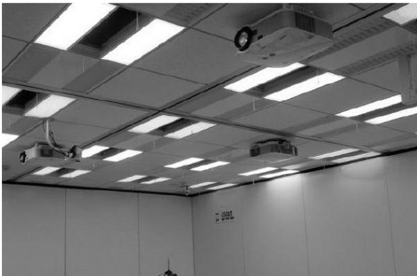
写真: 知的照明システム(照度と色温度を制御)
