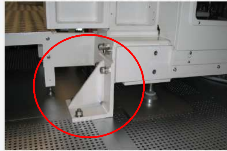
重量機械 耐震固定
