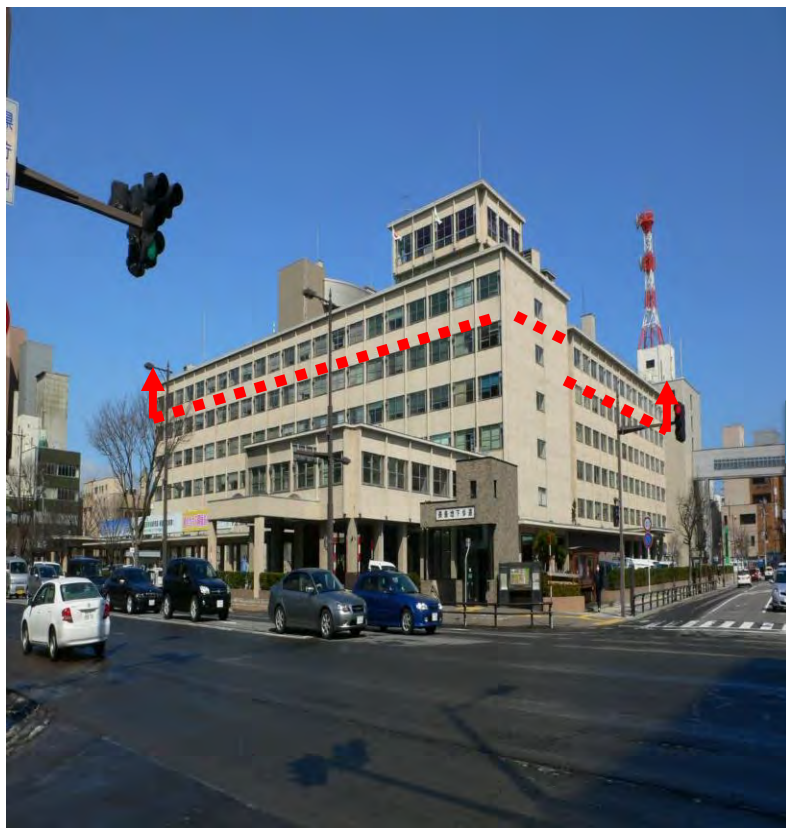
改修前（平成26年）
