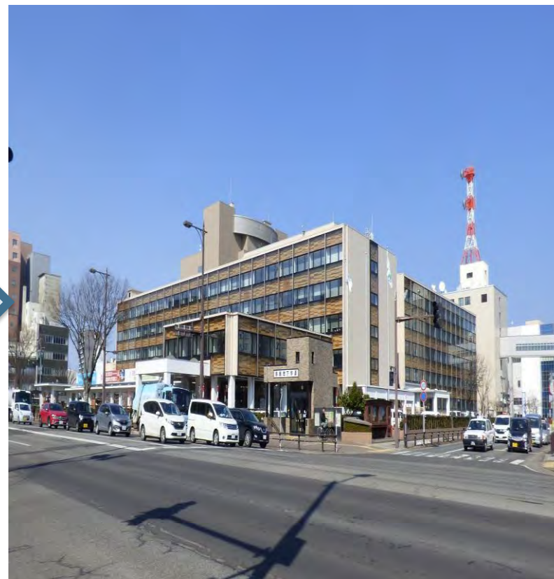
改修後（平成30年）
