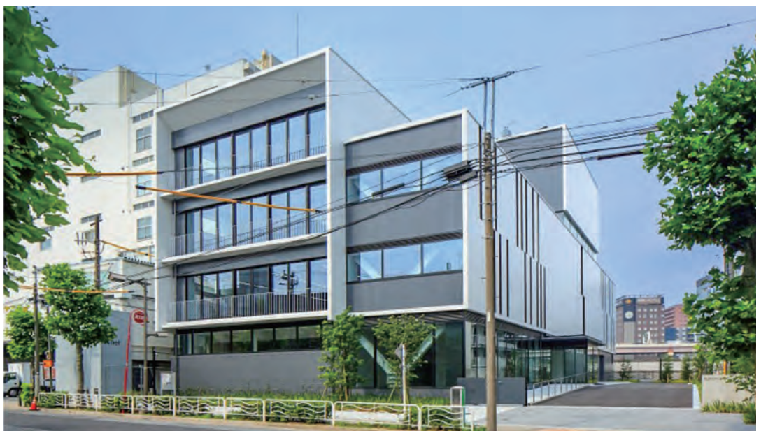
NTTファシリティーズ新大橋ビル
