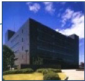
安田生命事務センター
