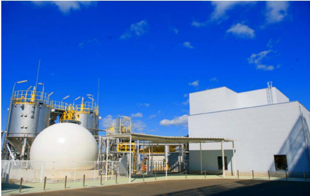
メタン発酵システム
